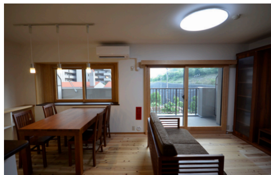
▲実際に内窓と置き床を取り付けたリビングスペース。ただ機能的なだけでなく、木の温かみを感じられる空間になっている
