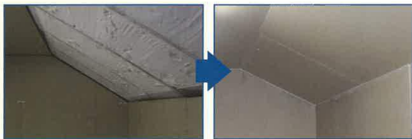
小屋裏収納や勾配天井は吹き付け後トリミング(カット)の後、ボードを貼って仕上げます。※2
