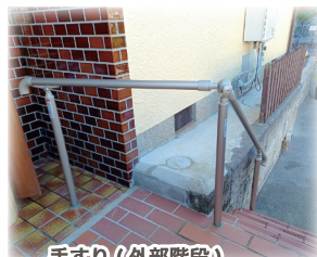
手すり (外部階段)
