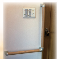
L型手すり (室内)
