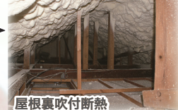
屋根裏吹付断熱
